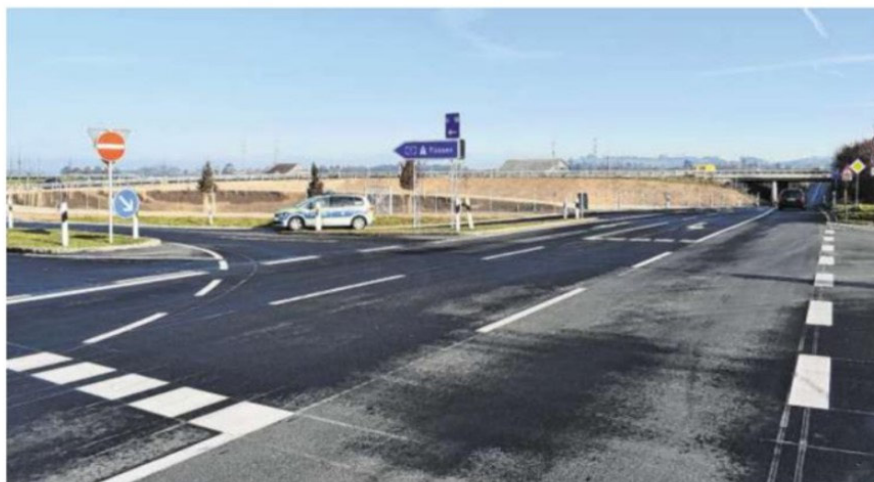
Die Auffahrt zur A7 bei Woringen ist nun wieder möglich. Nach vier Monaten Bauzeit ist der Bau der neuen Versickerungsanlage (im Bildhintergrund) abgeschlossen. Zudem wurde die Deckschicht der Kreisstraße in diesem Bereich erneuert. Foto: Franz Kustermann
